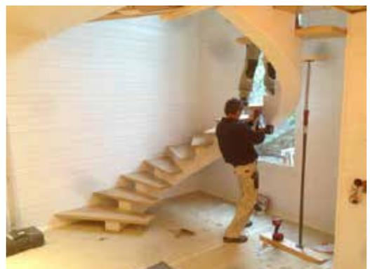
12. Montando el sistema invisible. Una vez desencofrado, aprovechamos al tener la zanca en su posición para marcar unos puntos de referencia desde el trazado al suelo
