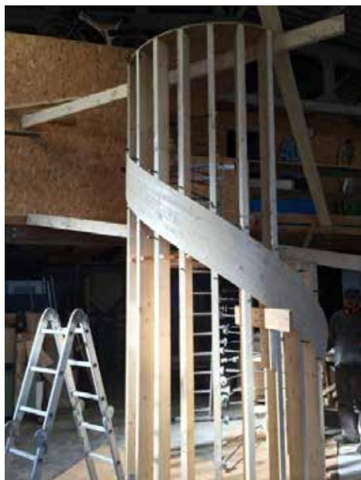
2. Después de preparar la torre según el radio interior de la zanca y a punto para encolar. Tras colocar la lama mártir sobre el molde se añaden las 28 laminas regruesadas a 7 mm. El suelo esta mojado con el fin de subir el nivel de humedad en el taller para alargar el tiempo abierto de la colla y dejarnos más tiempo de maniobra
